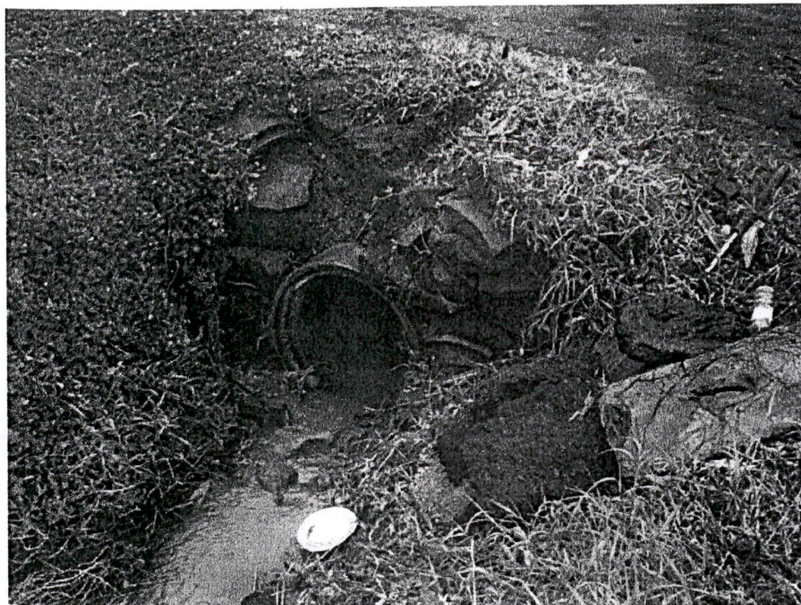
FALTA DE UN CABEZAL DE CONCRETO PARA CONDUCIR EL AGUA (FOTOGRAFIA COSTADO SUR INTERSECCIÓN)
