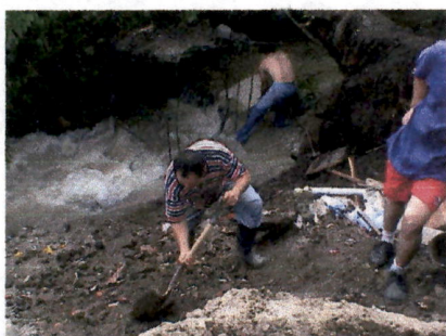
Composición del talud, básicamente material de relleno.
